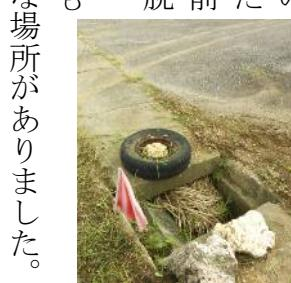
①東平安名崎北側の改良区内の農道ですが、T字路の側溝の蓋がだいぶ前にから脱落し、落とても
